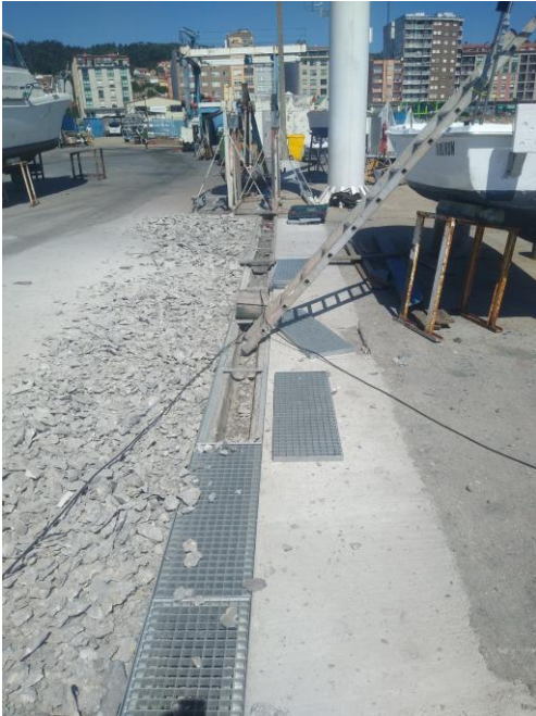
Ilustración 8. Instalación de rejilla en zona de varadero para asegurar correcta gestión de residuos generados en actividades de limpieza y mantenimiento de embarcaciones.
